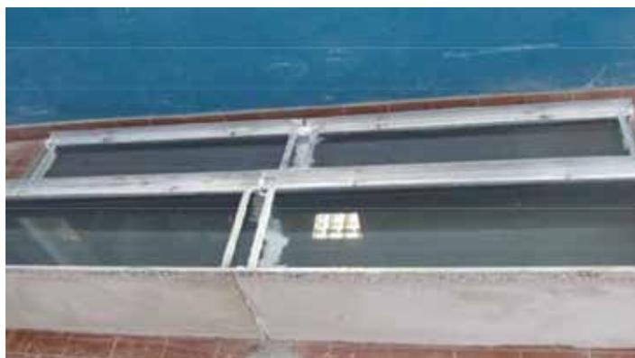
**CON UN'ADEGUATA POSA IN OPERA E SIGILLATURA DEL GIUNTO IL CANALE DIVENTA ERMETICO. OGNI PRODOTTO (GESTITO SOTTO MARCATURA "CE") VIENE FORNITO CON DICHIARAZIONE DI PRESTAZIONE (DOP) COME PREVISTO DAL REGOLAMENTO 305/2011 SUI PRODOTTI DA COSTRUZIONE.**
